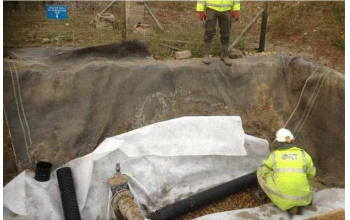
REPAIRS TO FAILING LANDFILL CAP DRAINAGE
