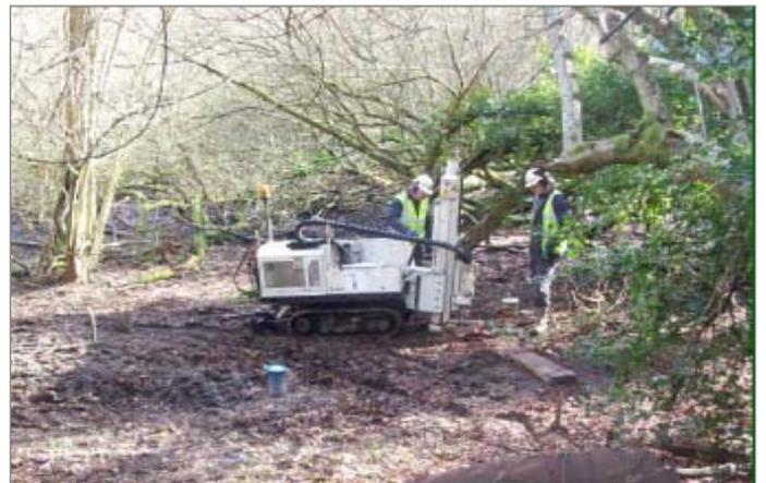
GEO PROBE RIG INJECTING ZVI SLURRY
