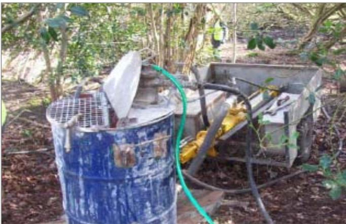
MIXING ZVI SLURRY AND HIGH PRESSURE INJECTION PUMP
